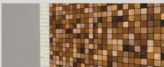
Los tiempos de instalación de superficie dependerán de las condiciones del lugar de trabajo y las recomendaciones del fabricante, pero podría pasar 12 horas entre la última capa de impermeabilización y colocación de las cerámicas.
