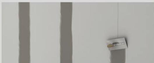
Instalar paneles de yeso / cemento en Zonas húmeda- Los paneles son pesados y la instalación es lenta y desordenada para cortar. Los paneles de yeso/cemento pueden requerir parches o perder su revestimiento antes de la instalación de membranas impermeabilizantes líquidas o laminas.
