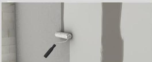
Aplicar al menos dos capas de impermeabilización en toda la superficie. La primera mano a las 11:00 am. Algunos productos líquidos requieren cinta de malla. Membranas impermeabilizantes requieren una gran cantidad de adhesivo.
