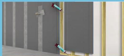
Instale los paneles de construcción wedi® utilizando sólo la mitad de la cantidad de elementos de fijación. Tratar con cola polimera wedi® 610 y cinta de refuerzo en las uniones de los paneles
