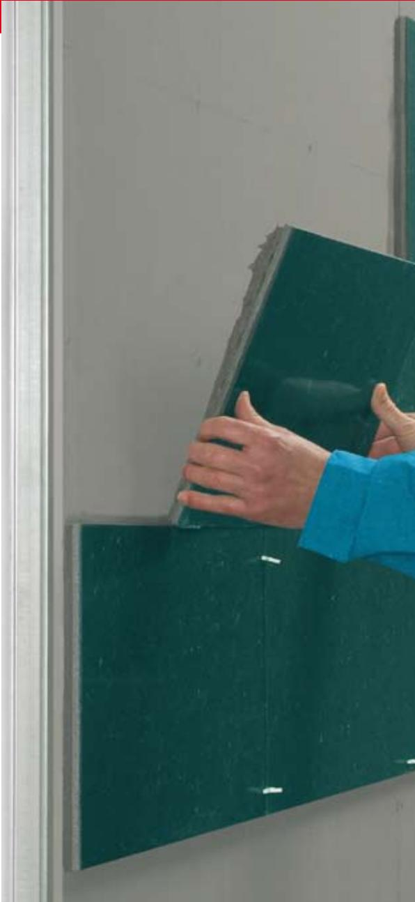
BEKRON STEEL ES UN MORTERO ADHESIVO TÉCNICO DEFORMABLE, DE ALTO DESEMPEÑO, ESPECIALMENTE DESARROLLADO PARA MUROS. SU FÓRMULA ASEGURA ÓPTIMOS RESULTADOS EN LA COLOCACIÓN DE REVESTIMIENTOS DE MUROS:
