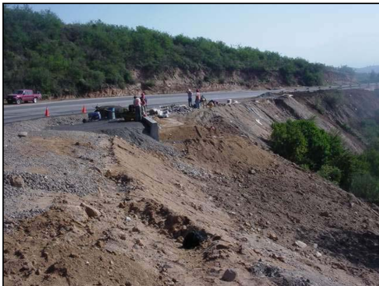
FOTOGRAFIA 9.604.2.A MEJORAMIENTO SISTEMA DE DRENAJE
