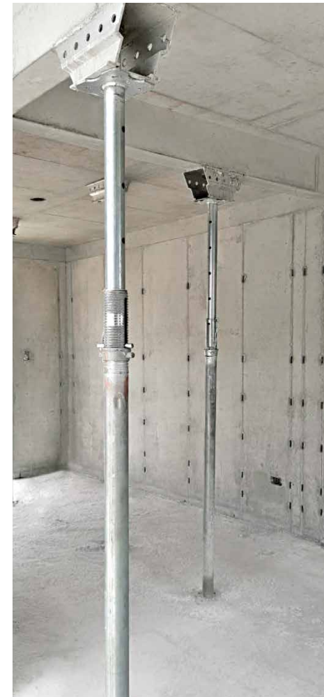
Los puntales permanecen sin interrupción luego de que la losa se desencofra.
