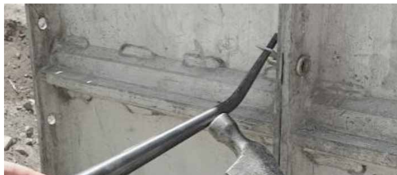
Permite la extracción sencilla de las cuñas.
