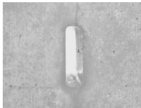
Detalle de desencofrado
