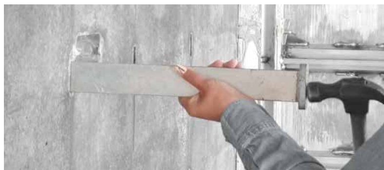
Las fundas provistas por MEVA son un insumo recuperable y pueden ser extraídas fácilmente utilizando el Extractor de Fundas.
