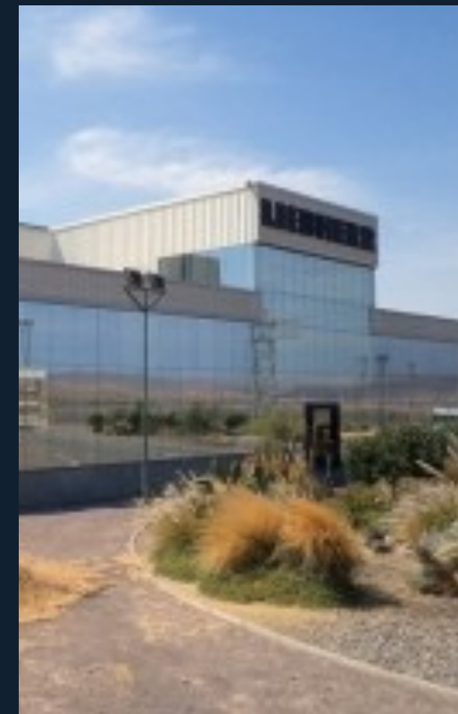
El centro de mantención y reparación de partes y piezas de recambio en el sector de La Negra en Antofagasta
