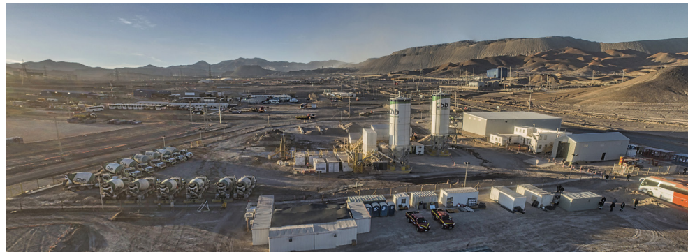
En Chuquicamata Subterránea, Cbb Ready Mix concentra la producción en una sola unidad que contiene dos plantas capaces de suministrar el total de los hormigones al interior de la mina.
