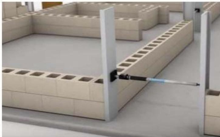
los cuales se colocan de forma vertical en conjunto con unos puntales para así vencer el empuje horizontal que ejercen los bloques sobre estos.
