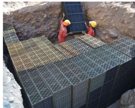
2.- Colocación en la zanja
