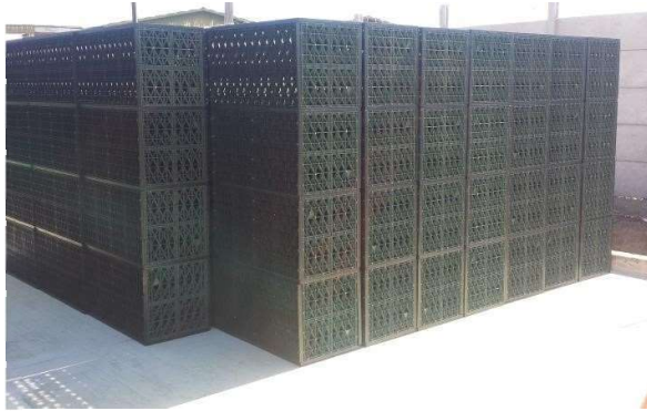
1.- Armado de módulos
