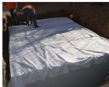
4.- Colocación Geotextil
